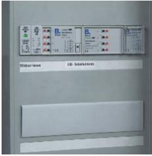
Защитное устройство VF ...-AC/DC является разрядником для защиты от перенапряжения / защиты отдельных объектов типа 3 (класса D) согласно DIN EN 61643-11 для защиты оконечных устройств от опасных перенапряжений. Защитная система из газонаполненных разрядников и варисторов подвергается постоянному температурному контролю. Функциональный индикатор сигнализирует о возникновении помехи или дефекта. Версия FS снабжена телесигнализацией с беспотенциальным переключающим контактом.
